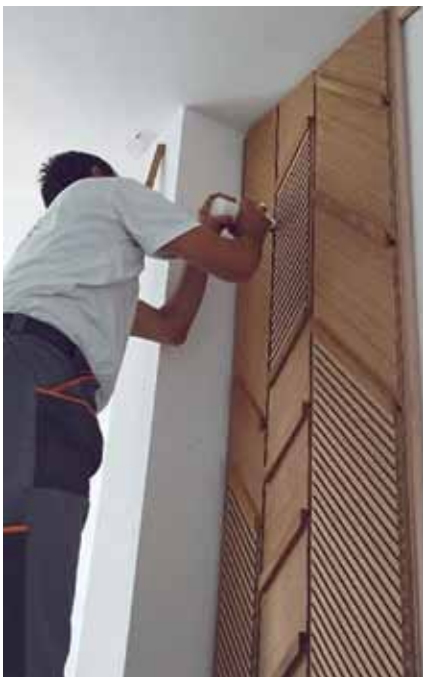
Nanošenje lepka u utore podkonstrukcije obloge tokom montaže
