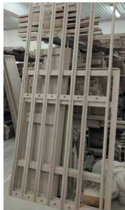
Formirana potkonstrukcija zidnih obloga spremna za montažu
