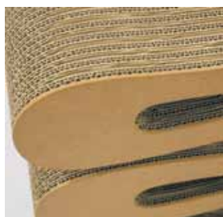
Detalj stolice Wiggle na kojoj se vide poprečni preseci kartona, kao i rubni profili koji su zbog trajnosti komada izrađeni od ploče vlaknate.
