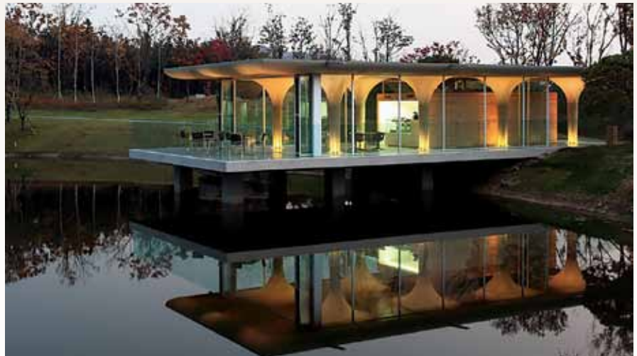
Objekat za venčanje od prefabrikovanog drveta u Japanu
