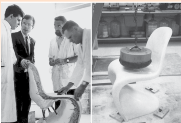
Sa novim polimerima, razvijane su nove tehnologije – model levo je primer livenja u kalupu, a model desno izrađen je tehnikom ubrizgavanja u kalup.
