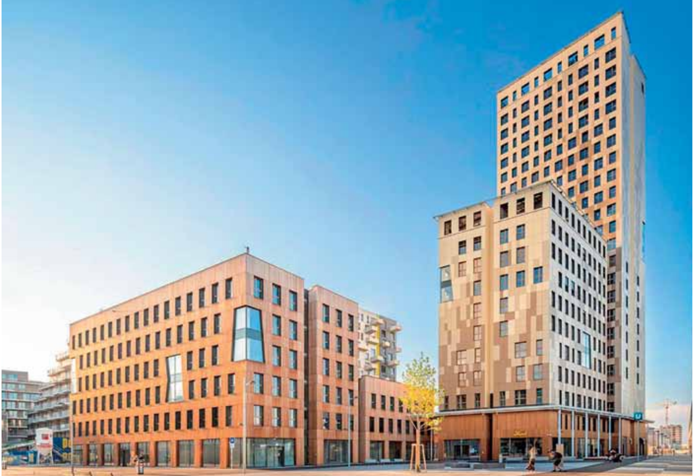
HoHo toranj u Beču, visok 84 metra, izgrađen je korišćenjem 365 metara kubika GLT-a i 1.600 metara kubika CLT-a. Prema proceni za proizvodnju ovih materijala bilo je potrebno oko 4.100 metara kubika oblovine
